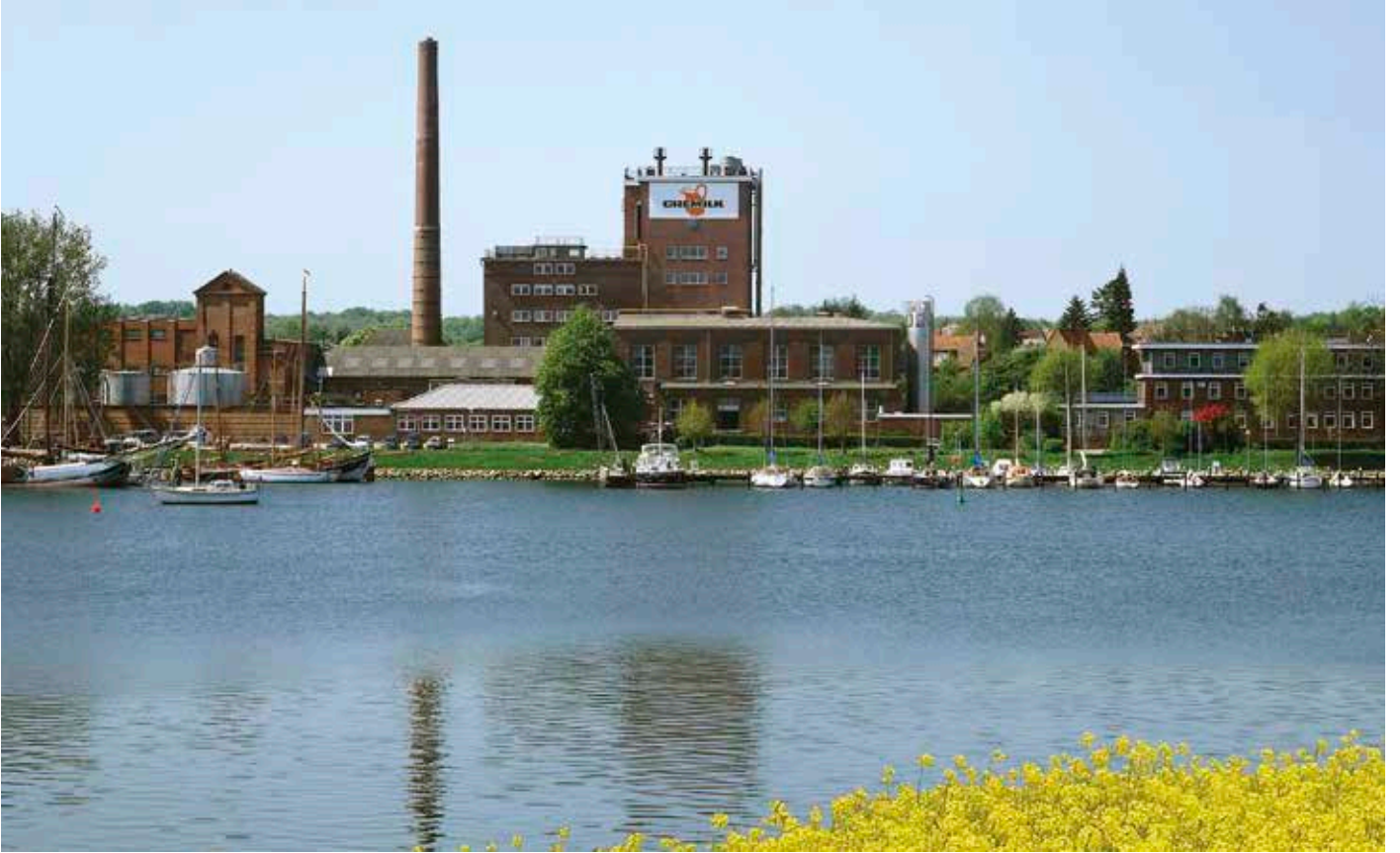
Produktions- und Verwaltungsgebäude der CREMILK in Kappeln an der Schlei. The CREMILK production plant and office buildings in Kappeln at the Bay of Schlei.
