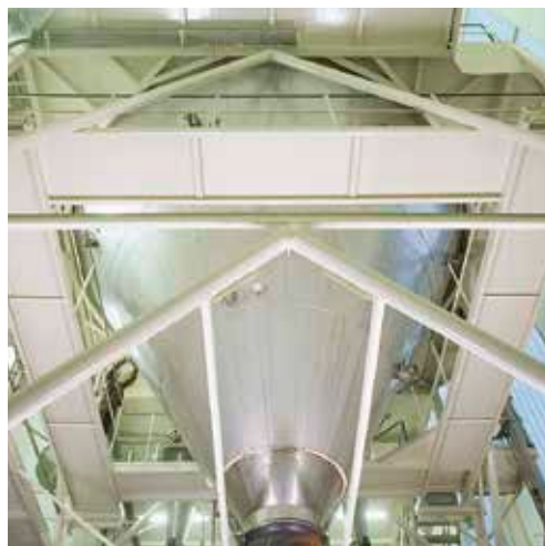
Tray packer und Palettieranlage (links). Im Sprühturm werden die Zutaten für die Cappuccino-Produkte getrocknet (rechts). Tray packer and palletisation (left). The ingredients for cappuccino products are dried in the spray tower (right).
